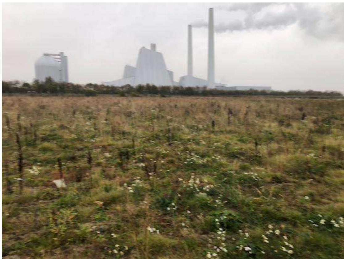
Foto: Slutafdækning på AV Miljø
