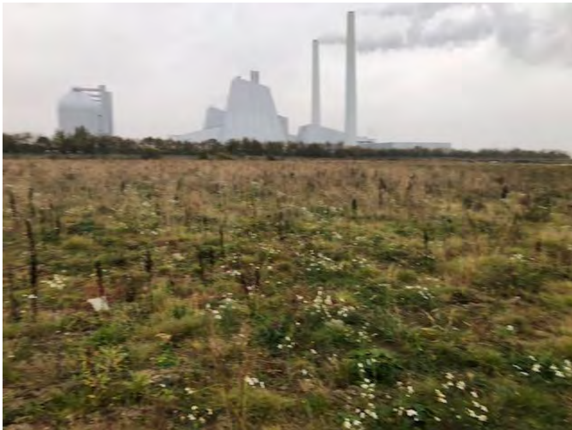
Foto: Slutafdækning på AV Miljø
